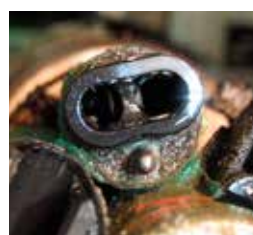
Capteur CT avant les mesures d'antifouling. La brosse de nettoyage n'a pas pu atteindre l'intérieur du capteur.
